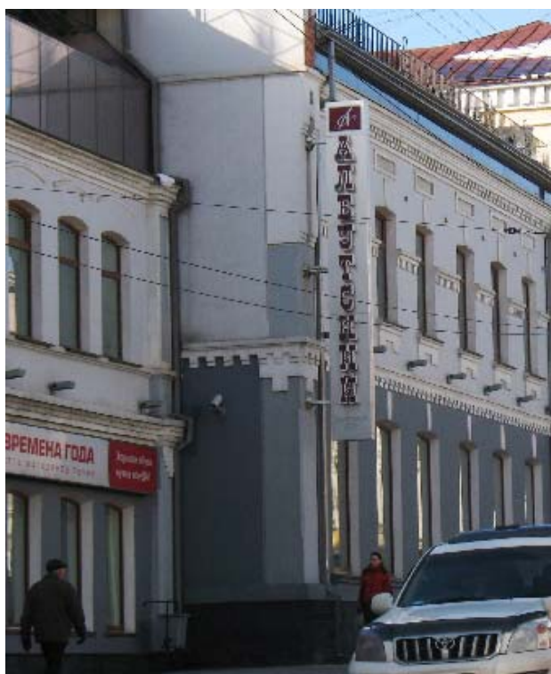
Кронштейн консольного типа на здании
